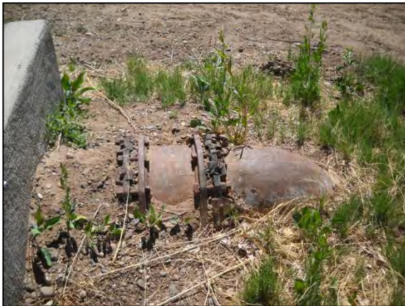
Effluent Discharge Pipe
